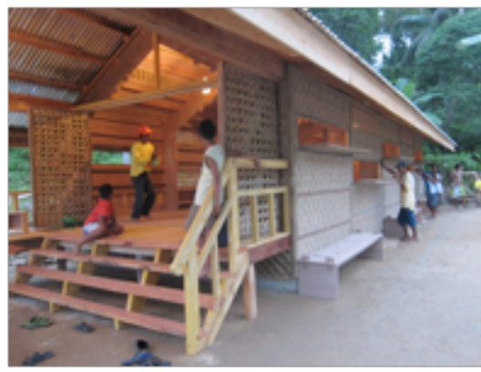
ボホールベニアハウス 左:骨組み組み立て 右:竣工
