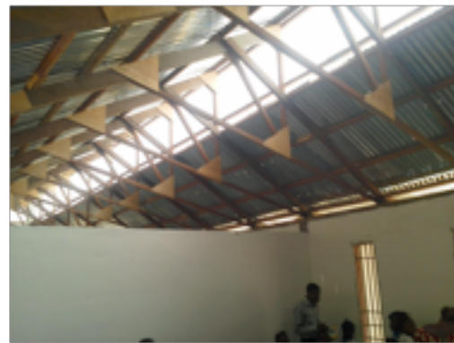
アカデックス小学校第3校舎屋根工事 左:工事中 右:終了
