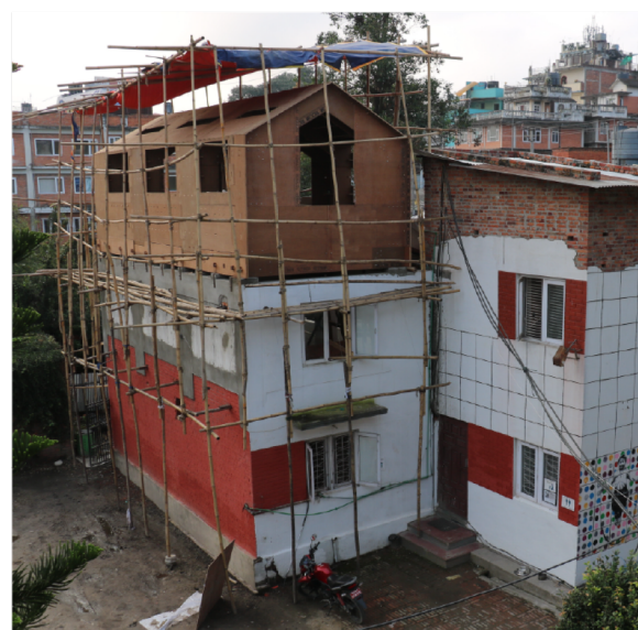
足場を用いた3階部分での施工
