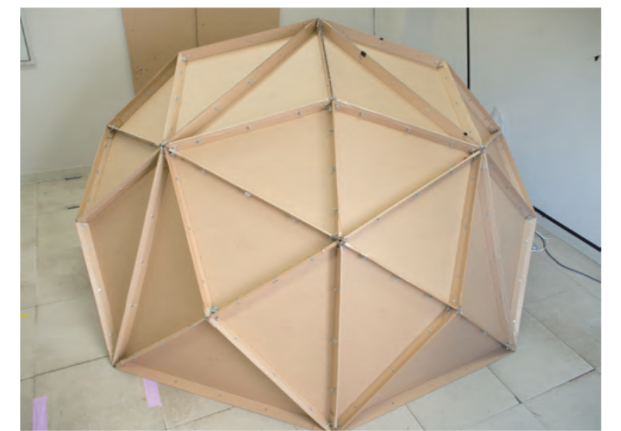
6, オクタユニットを 4 つ組み合わせて、ドームの「北半球」を作る。
