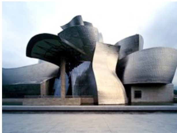
図1-1 フランク・O・ゲーリー設計 ビルバオ・グッゲンハイム美術館 http://www.guggenheim-bilbao.es/img/all/el_museo/foto_postal_08.jpg
