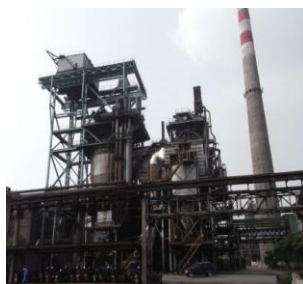
図 12 プロジェクト後の CDQ 設備操作の様子（漣鋼）
