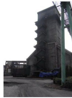
図 13 操作停止の CWQ 設備（漣鋼）
