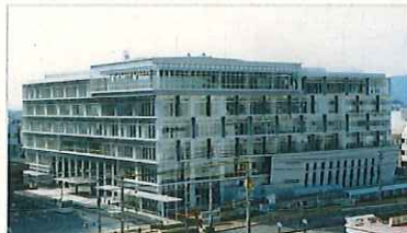
▲外気と内部が絶縁されている建物-岩国市庁舎
