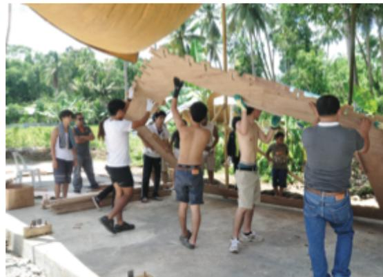
置にセットした。 リブの端部がフック状になっているので、家型フレームの位置も同時にセットされた。次に壁パネルを取り付け、最後に楔型パネルを木槌でたたいて締結する。両側に1セットずつ締結されたらひとまず構造体として自立させた。上部のパネルについても同様に固定していく。下部は特殊根太パネルを室外側から壁パネルを設置する前につける必要があり、また2スパン家型フレームがないと固定ができないので、あとまわしにした。
