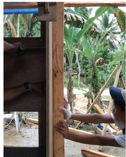
合板フレームと抱き合わせる形で柱材を取り付ける。柱材を押し付けて反りを矯正しながら釘を室内側から固定する。
