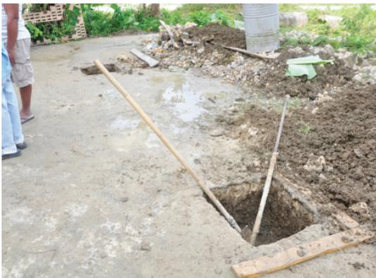
地下水および時々降る雨水が溜まってしまうため、その都度バケツで水を移動させる。
