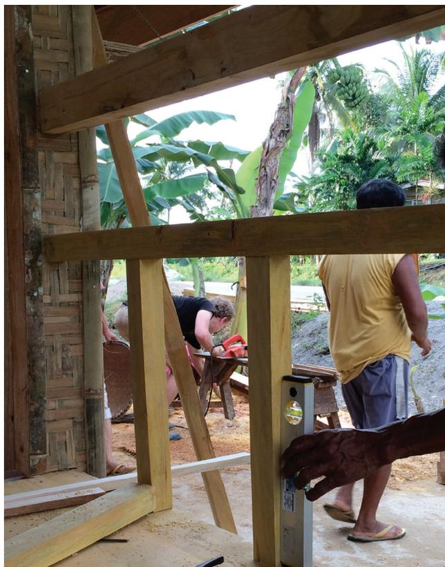
支柱と手すり子の直角は水平器を用いて確認する。
