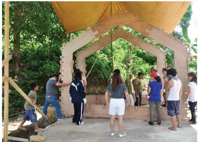
次工程の壁材が固定されるまではフレーム両端に最低2人で倒れないよう支える。
