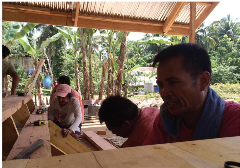
踏み板の設置。桁の平行を確認しながら固定
