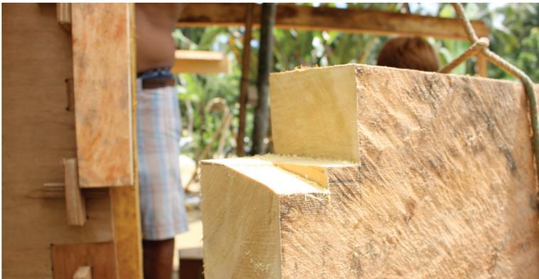
軒桁:合板フレーム側の継手加工
