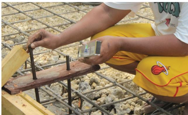
③設置したガイドとアンカーボルトの水平を確認。
