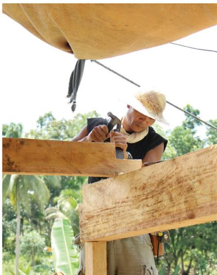
③梁: 継手加工と設置
