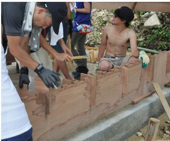
①端部の根太パネルを家型フレームのスリットに差し込む
