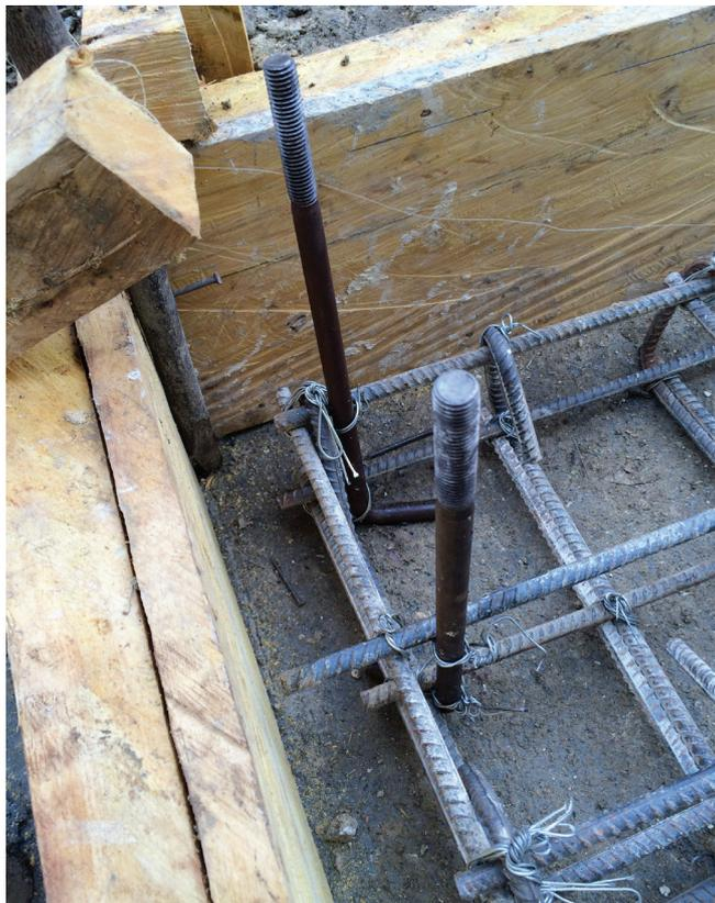
②アンカーボルトを結束線で鉄筋に固定。
