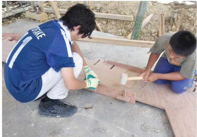
継手箇所:2種類のパーツにて結合させる
