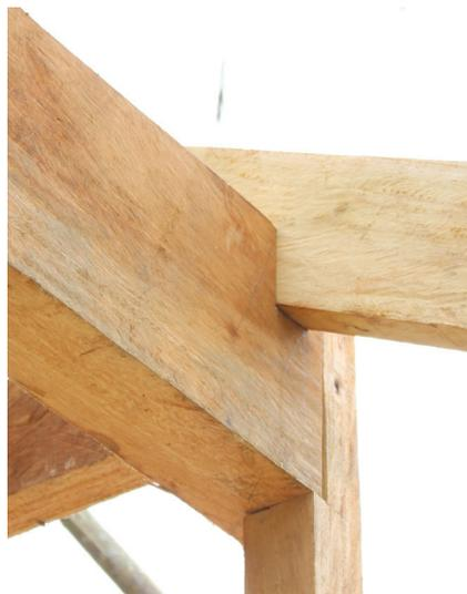
垂木: 軒桁材を加工して設置
