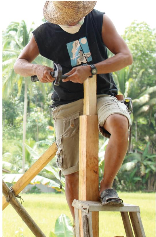
柱の継手加工を設置後に再度行う事で調整
