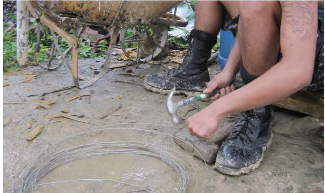
金槌を打ち付けて結束線を所定の長さに切る。
