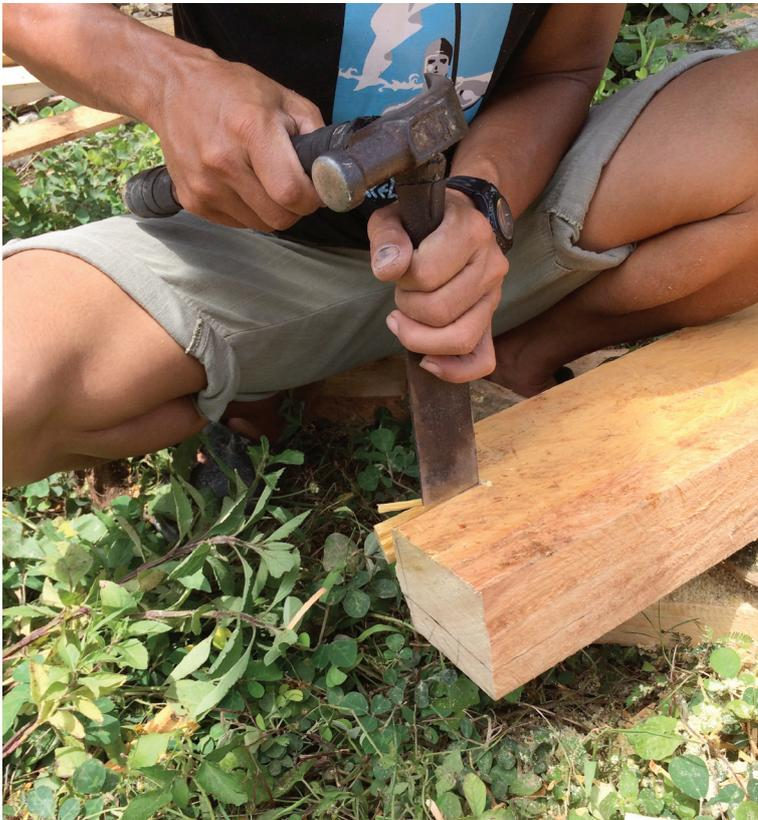
ノミによる継手の加工
