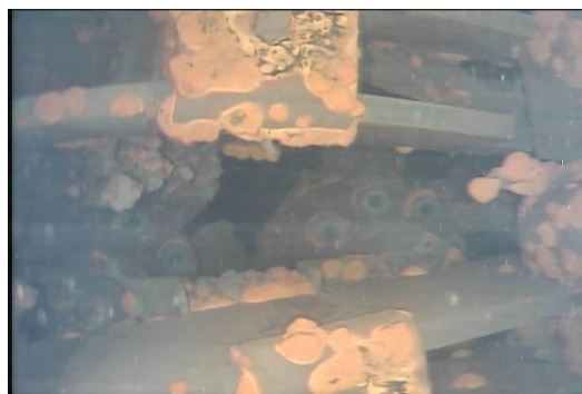
図 1. 福島第一原子力発電所 3 号機 原子炉格納容器の内部
