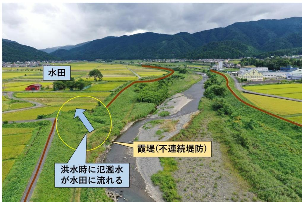
Fig. 5 霞堤の仕組み
