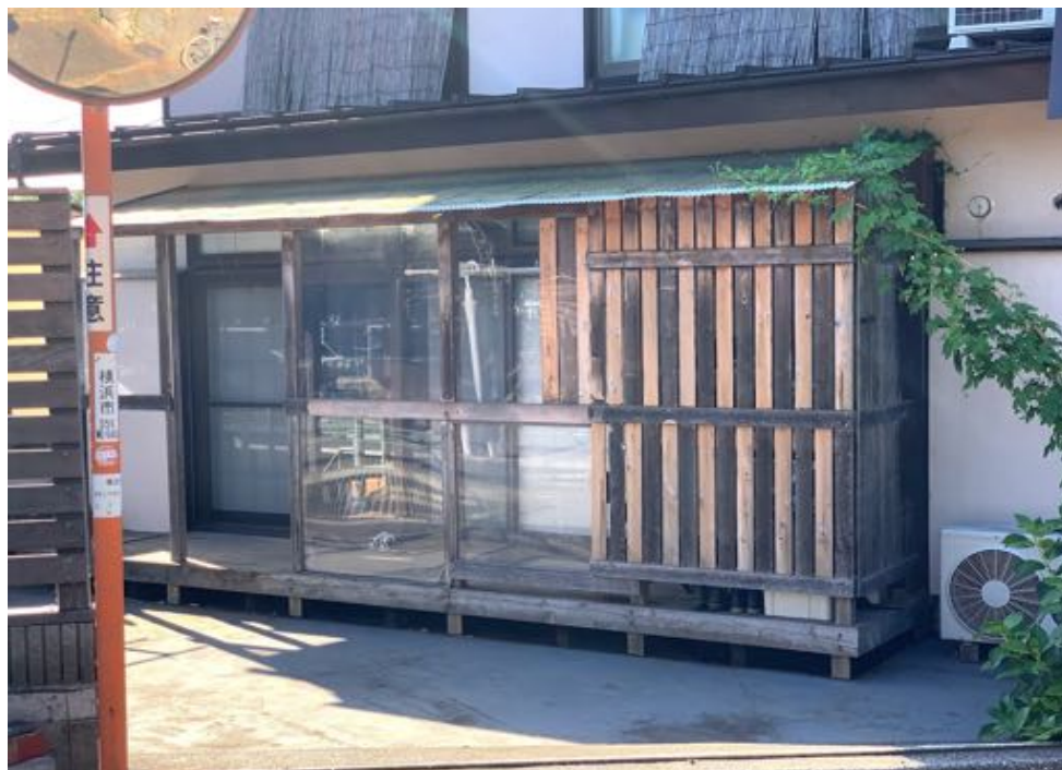
fig. 6-12 木の板材を用いたルーバー とその固定法 (筆写撮影)
