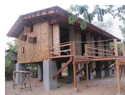
現地材による外装仕上げ
